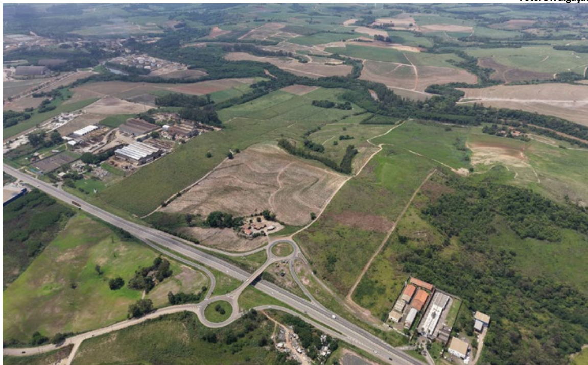
Anel Viário Norte ligará a SP-127 (Piracicaba-Rio Claro), na altura do Cruz Caiada, à rodovia Hermínio Petrin (Piracicaba-Charqueada), no dispositivo de acesso ao bairro Santana
